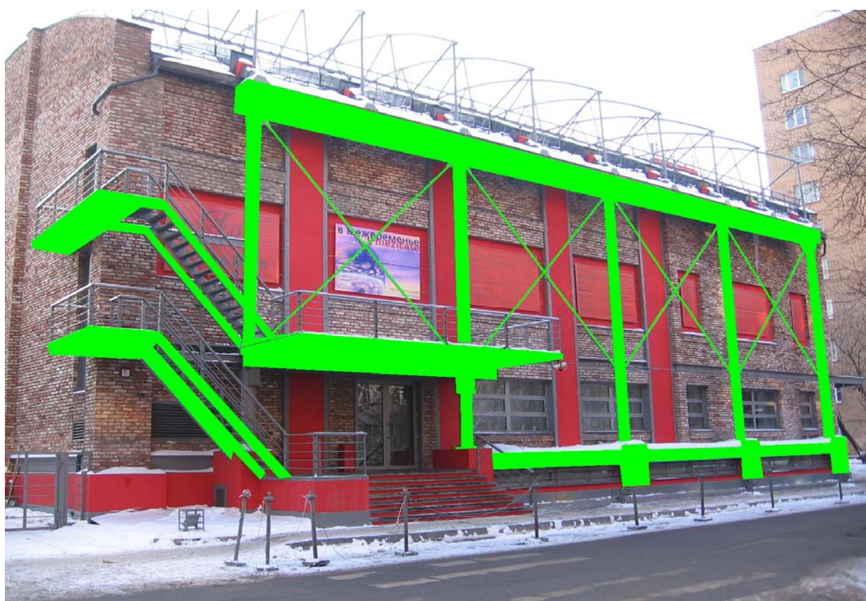
Рис.3.9. Выделение отступающих от фасада здания архитектурных элементов для замены их на 3D аналоги
